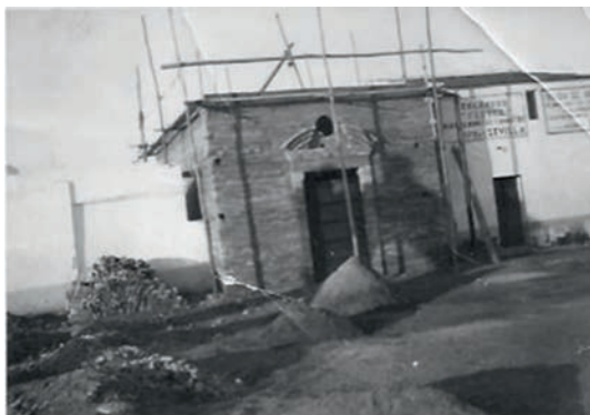
Fachada en obras.
